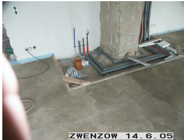
Vorbereitung der Anschlussleitungen im Aufstellbereich
