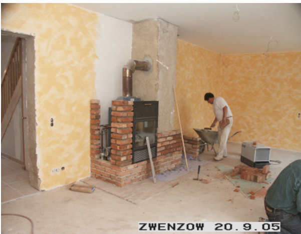
Die neue Verkleidung wird erstellt.
