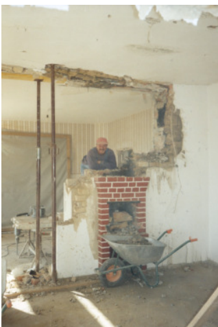
Abbruch des alten Kamins
