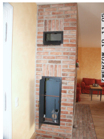
Blick in den Installationsraum
