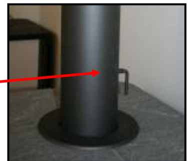
Vertikale Stellung = Klappe geöffnet
